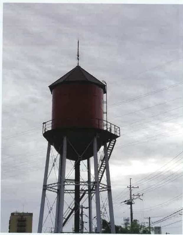
配水塔（高砂市高砂町朝日町） 1966年に浄水場が移り役目を終えたが、水道事業の創設記念にと塔は保存。高砂市文化会館駐車場内にあり、国の登録有形文化財になっている。
