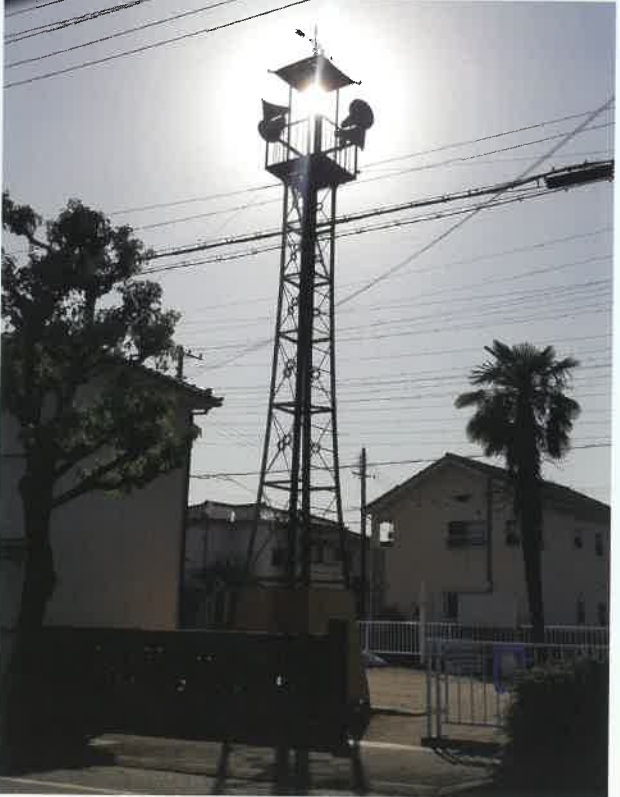
鉄製の火の見櫓（高砂市荒井町） 火の見櫓をお目にかかれる場所は今は少ない。現在は防災無線スピーカーがついている。
